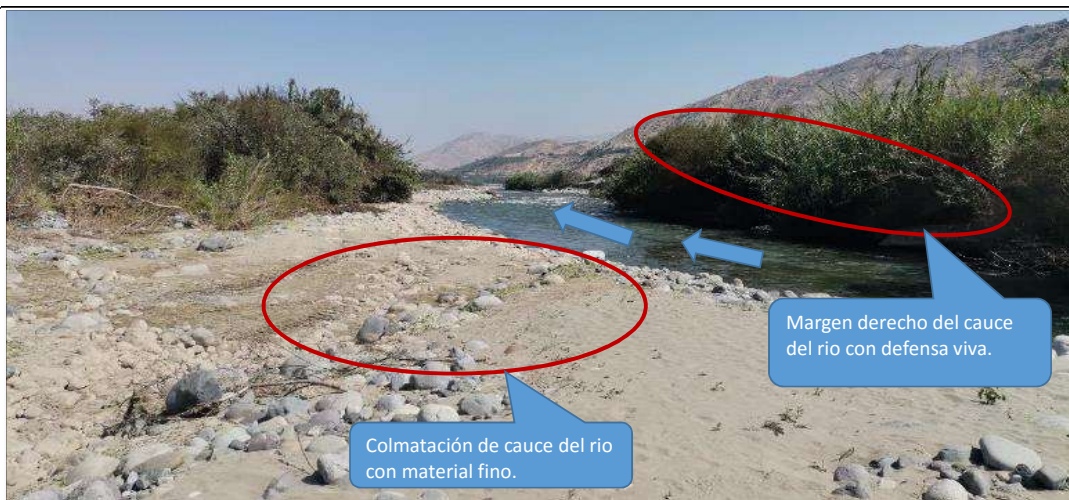
FIGURA N°04: DEFENSA VIVA EN LA MARGEN DERECHA DEL RIO CHANCAY - HUARAL EN EL SECTOR QUIPULLIN - BOCATOMA CUYO.
