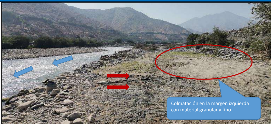
FIGURA N°01: RIO CHANCAY - HUARAL COLMATADO EN EL SECTOR QUIPULLIN - BOCATOMA CUYO, CON LA PRESENCIA DE: VEGETACIÓN, ARENA FINA Y MATERIAL GRANULAR; LAS CUALES DEBEN SER DESPLAZADOS HACIA AMBOS MARGENES PARA MANTENER SU SECCIÓN HIDRÁULICA .
